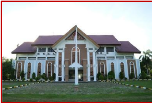
Gambar 2.1 Gedung Biro Rektor
