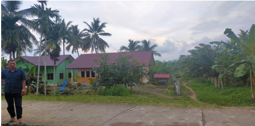
Gambar 4.5 Kondisi sekolah di Gampong Lhokcut
